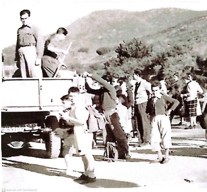
Treballs de reconstrucció de l'ermita de Sant Onofre amb l'Arcadi Duran dalt del seu camió. 1956
